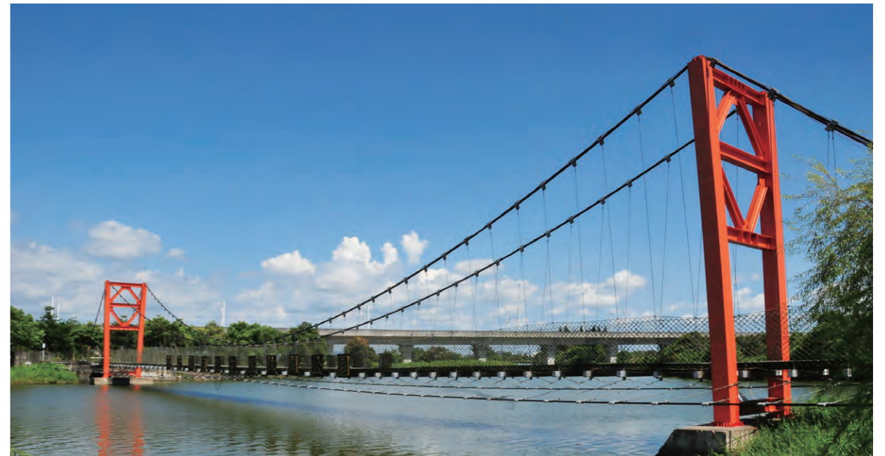
有著鮮紅醒目橋身的凌波吊橋
