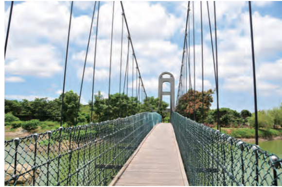
橫跨上茄苳埤的小南海吊橋
