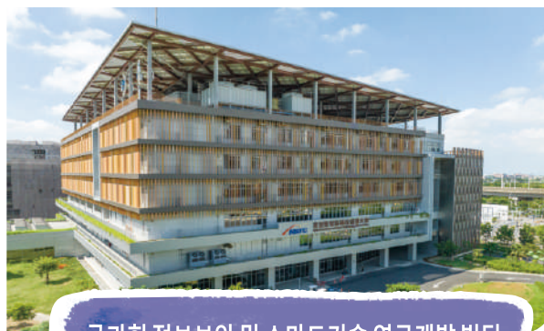
국과회 정보보안 및 스마트기술 연구개발 빌딩 國科會資安暨智慧科技研發大樓
