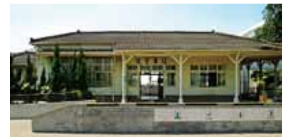
📍 後壁車站 是台南市最北的車站，為傳統木造建築，創建於1902年，民國32年改建為現有樣式，外觀為魚鱗板，基座為洗石子，是目前台灣僅存的日式木造火車站之一。
