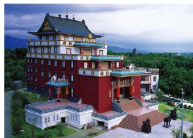
左鎮區·噶瑪噶居寺 Zuozhen District / Gamagaju Temple 左鎮區 噶瑪噶居寺 좌진구 갈마갈거사
